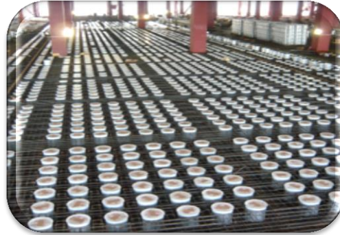
Grid Precast waffle slab
